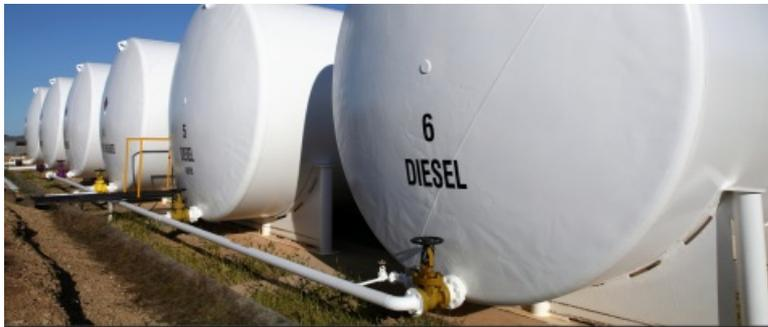
Os tanques ligados entre si permitem aos planeadores de armazenamento criar "o tamanho certo" das suas necessidades de armazenamento, utilizando tanto ou tão pouco armazenamento quanto necessário. Os tanques ligados podem mesmo ser utilizados para empurrar combustível entre reservas com equipamento especializado e bombas.
