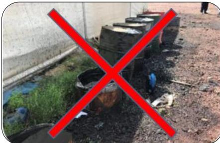
Ne mélangez pas des huiles et lubrifiants usés de différents types dans le même contenant et n'entrez pas les huiles et lubrifiants usés sans couvercle et sur un sol non protégé.
