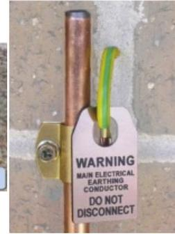
يتكون نظام التأريض عادةً من موصل تأريض، وموصل الترابط، وقطب التأريض الخاص به (عادةً ما يكون قضيبًا أو نظامًا شبكيًا)، والترربة الملامسة للإلكترود. يُمكن اعتبار القطب الكهربائي مُحاطًا بحلقات متحدة المركز من الأرض أو التربة، وجميعها بدرجة السماكة نفسها - كل حلقة متتالية لها قيمة مقطع عرضي أكبر وتُوفر مقاومة أقل وأقل حتى يتم الوصول إلى نقطة، تُضاف عندها مقاومة ضئيلة.
