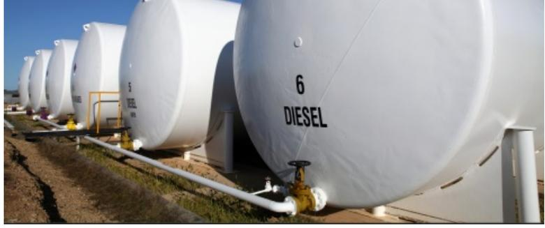
تتيح الخزانات المرتبطة لمخططي التخزين اختيار "الحجم المناسب" لاحتياجات التخزين الخاصة بهم، وذلك باستخدام قدر كبير أو صغير من التخزين حسب الحاجة. كما يُمكن استخدام الخزانات المرتبطة لدفع الوقود بين الاحتياطات بمعدات ومضخات متخصصة.
