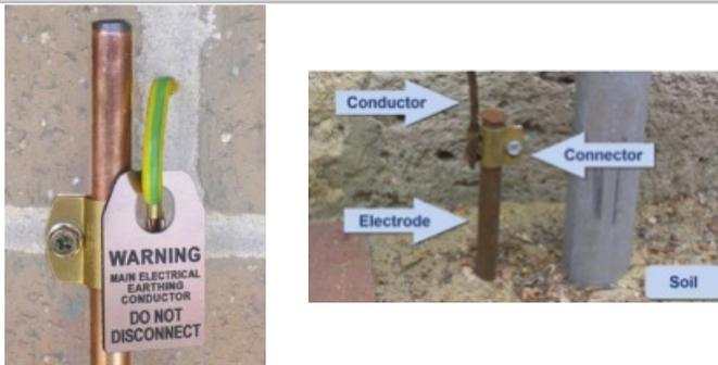
Система заземления обычно состоит из заземляющего проводника, соединителя, заземляющего электрода (обычно стержня или заземляющей сетки) и грунта, контактирующего с электродом. Электрод можно представить окруженным концентрическими кольцами земли или грунта, одинаковой толщины — каждое последующее кольцо имеет большую величину поперечного сечения и оказывает все меньшее сопротивление, пока не будет достигнута точка, в которой им добавляется незначительное сопротивление.
