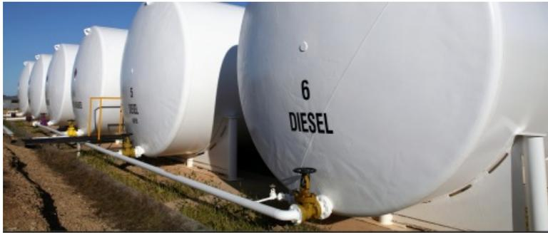
Los depósitos conectados permiten a los planificadores de almacenamiento adecuar éste a sus necesidades, de forma que se puede utilizar tanto o tan poco almacenamiento como sea necesario. Los depósitos conectados pueden utilizarse incluso para transportar combustible entre reservas con equipos y bombas especializados.
