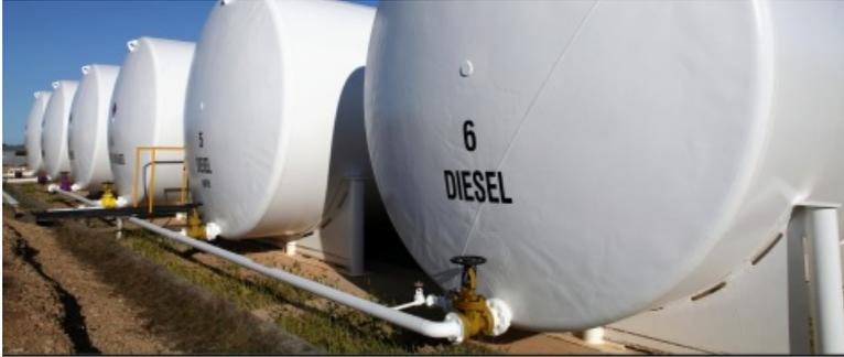
Les réservoirs liés permettent aux planificateurs du stockage de « dimensionner correctement » leurs besoins de stockage, en utilisant autant ou aussi peu de stockage que nécessaire. Les réservoirs liés peuvent même être employés pour pousser le carburant entre les réserves à l'aide de pompes et d'équipements spéciaux.
